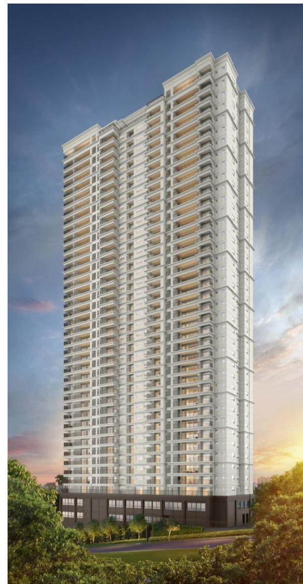
FACHADA GERAL TORRE B
